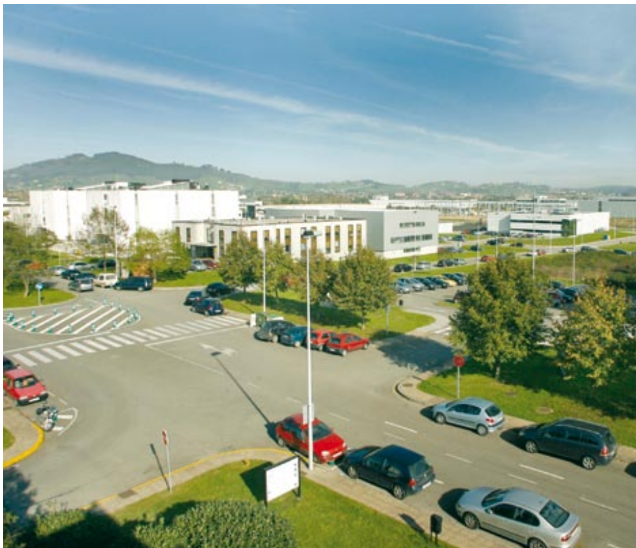
Instalaciones del Parque Tecnológico de Asturias, en Llanera.
