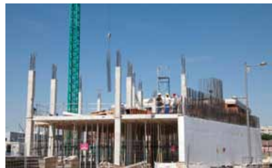
Los trabajos del nuevo edificio de Máster Diagnóstica ya han comenzado.
