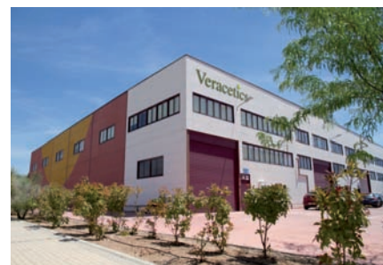
Edificio de Veracetics en Tecnópolis.
