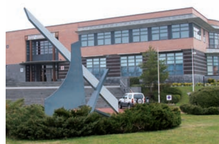
Vista del edificio central donde se ubican los nuevos servicios.
