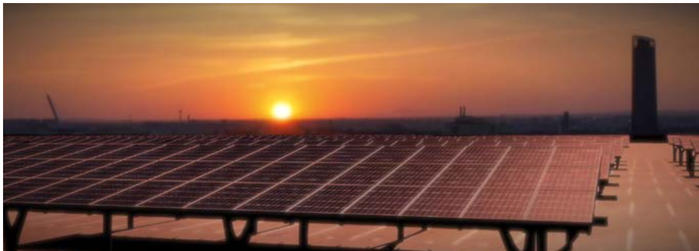
Recreación del parque solar fotovoltaico asociado al proyecto eCitySevilla
