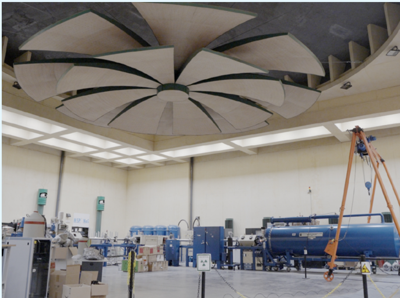
Vista de las instalaciones del Centro Nacional de Aceleradores (CNA), ubicado en Sevilla TechPark
