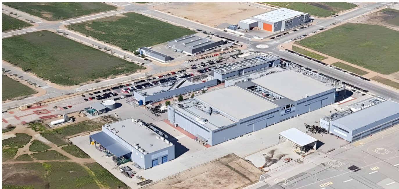
Instalaciones de Airbus Helicopters en Albacete
